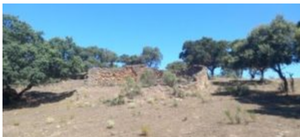
Imagen 8. Vista general del muro de Cumbre I
