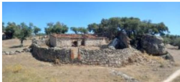
Imagen 7. Vista general del muro de Bocanegra
