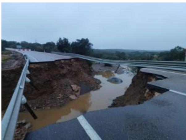
Figura 10. Rotura del asfalto y socavón en la carretera N-523 producido el 13 de diciembre de 2023. Fuente: Fotografía del Archivo de José Pastor Villegas.
