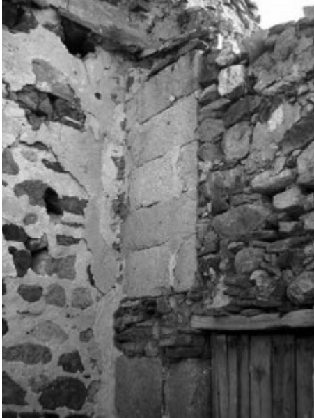
Lám XX - El contrafuerte de sillería de granito.
