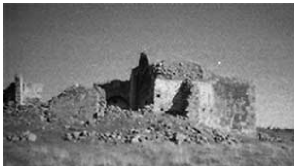
Lám XV - Ábside desde el sur. Obsérvese la prolongación externa del muro sur hasta la tronera.
