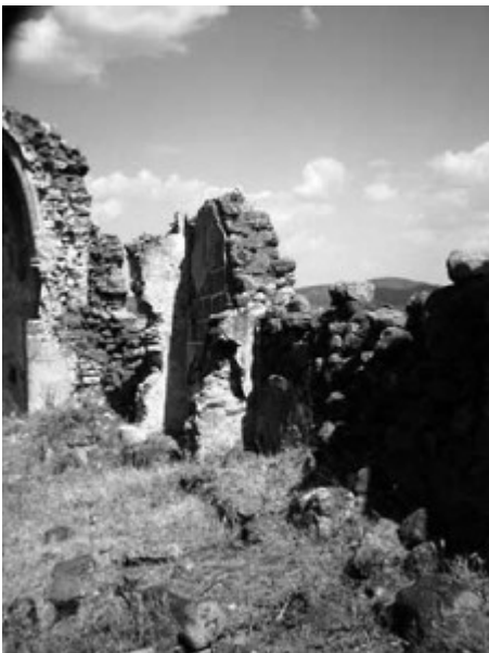
Lám XII - El ancho muro longitudinal del interior del lado sur.
