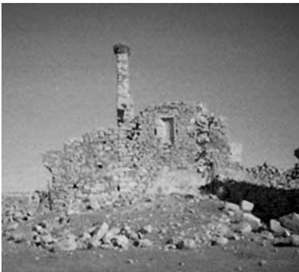
Lám XXIV. El refuerzo exterior de la esquina SW.
