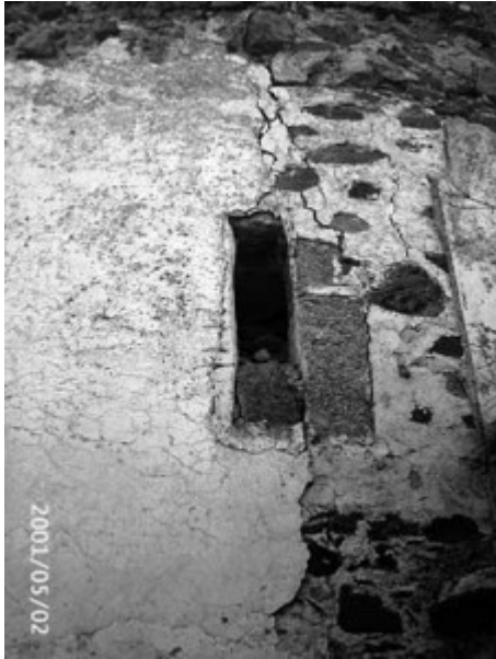
Lám XVIII - Ventana al norte, cegada al interior.
