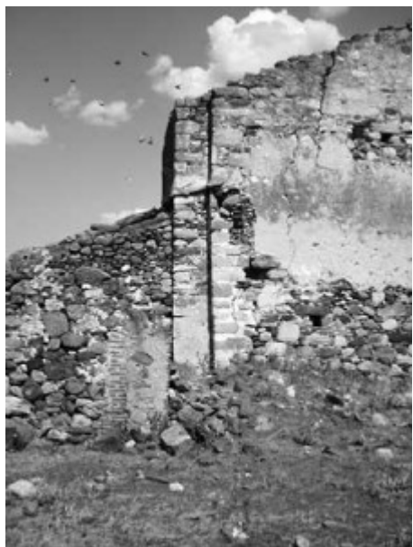
Lám XXI - La construcción en la esquina NW.
