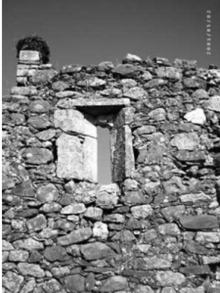
Lám XXIII- La ventana del lado S de la nave.
