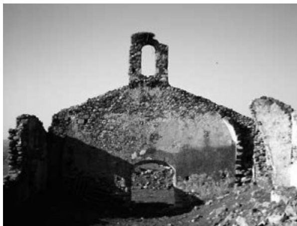
Lám XIV - Vista general del interior del muro sur.
