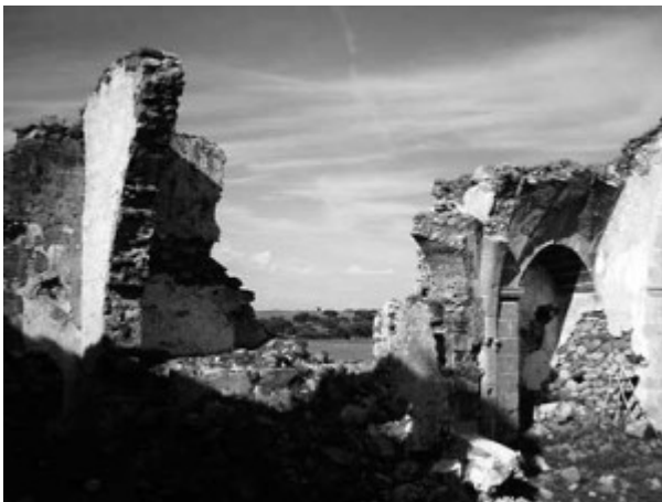
Lám VII - Los restos de las capillas laterales.
