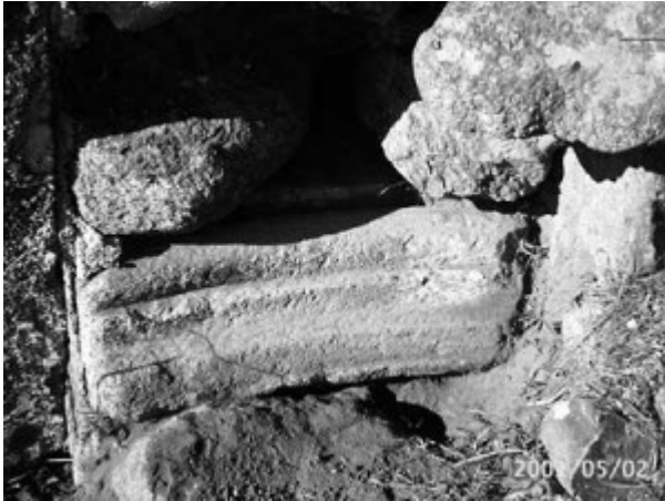
Lám XI - Dovela embutida de la esquina NW.
