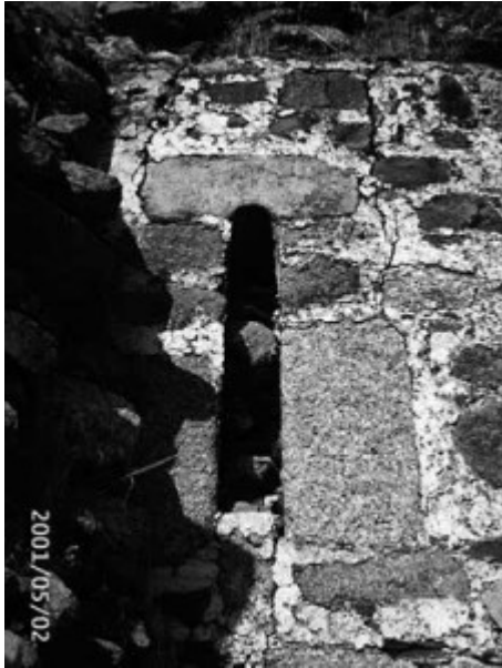
Lám XVI - Ventana al sur, cegada al interior.
