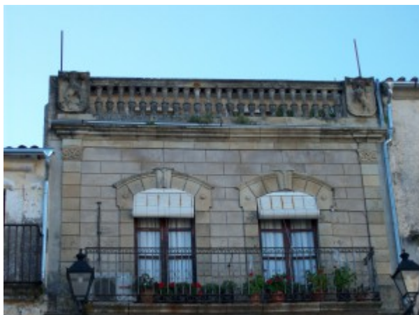
Figura 15. Balaustrada de balcón de una casa que los Bejarano tenían en la Plaza Mayor
