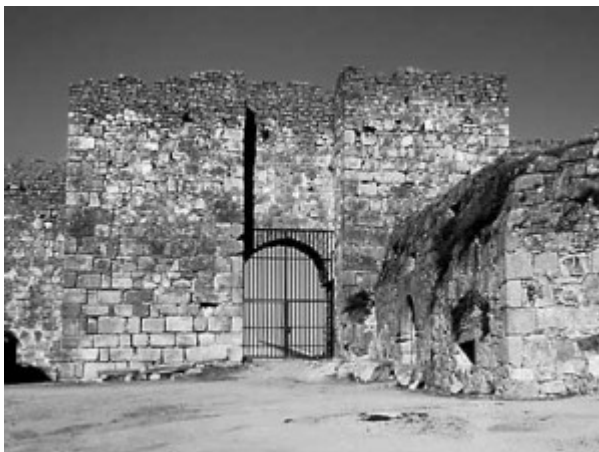
Vista del Baluarte del Castillo de Trujillo
