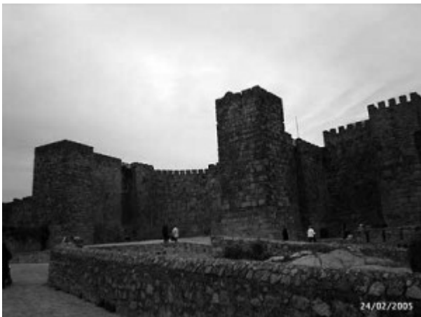
24/02/2005 Vista de las torres albaranas. Castillo de Trujillo
