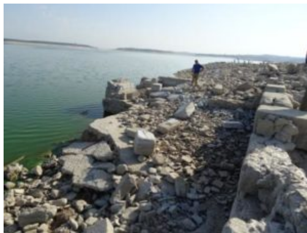
Figura 3.- Estado del area del caldarium de La Cantamora (Talavera la Vieja) en el
