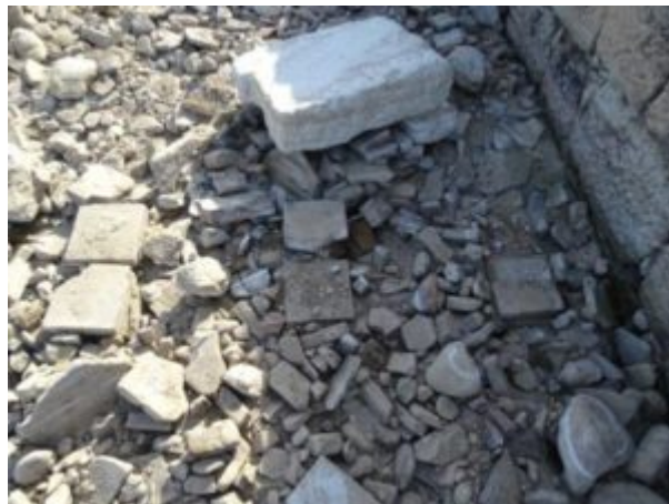
Figura 4.- Primeros ladrillos que daban inicio a las pilae de la suspensurae en las termas de La Cantamora (Talavera la Vieja).
