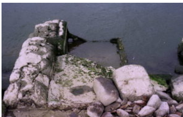
Figura 6.- Detalle de la cisterna de los Mármoles (Talavera la Vieja).
