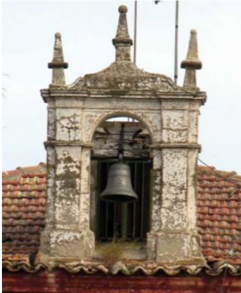
Casa de la Vega. Espadaña de la capilla
