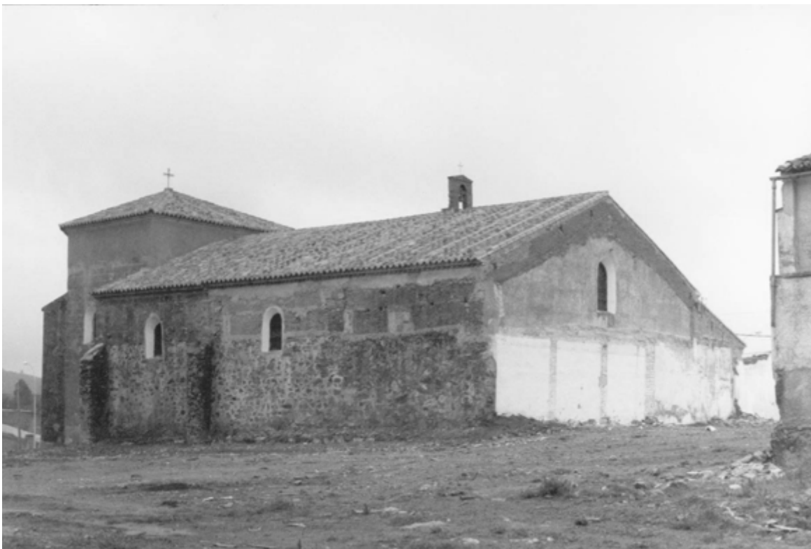
Lám. 8. Vista general de la ermita
