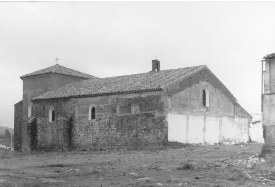
Lám. 8. Vista general de la ermita
