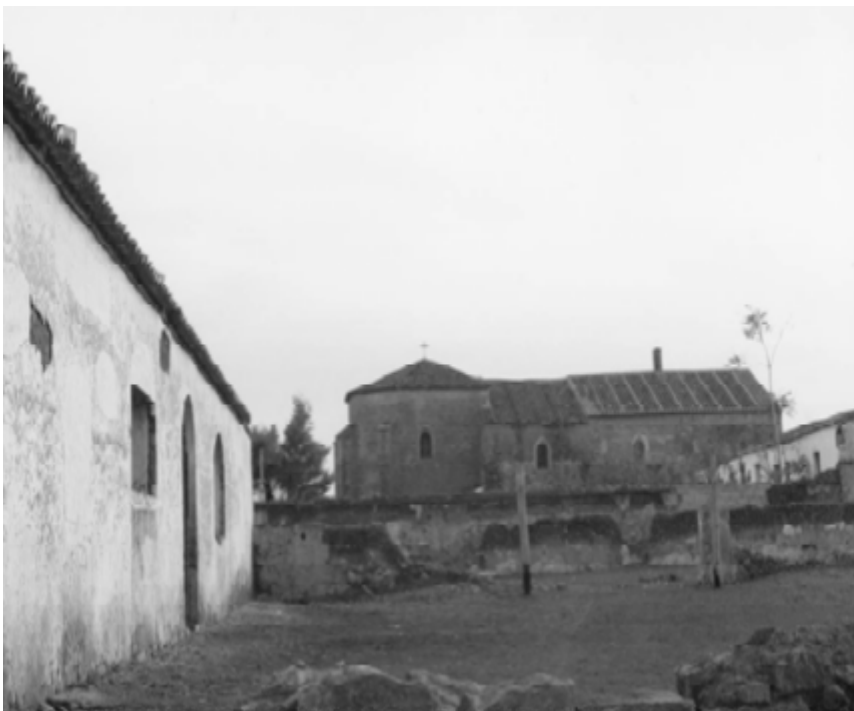
Lám. 14. La ermita rodeada de cercas y de edificios en 1980
