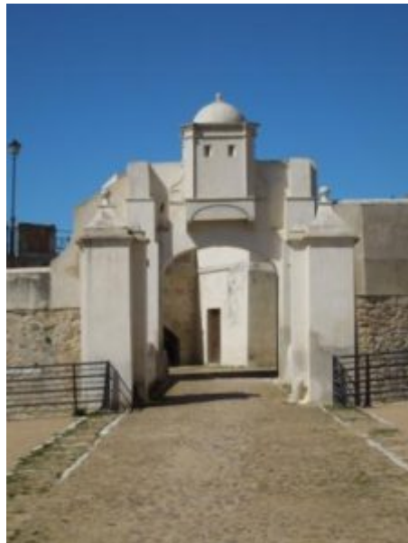
Fotografía 2.- Hornabeque del puente. Badajoz
