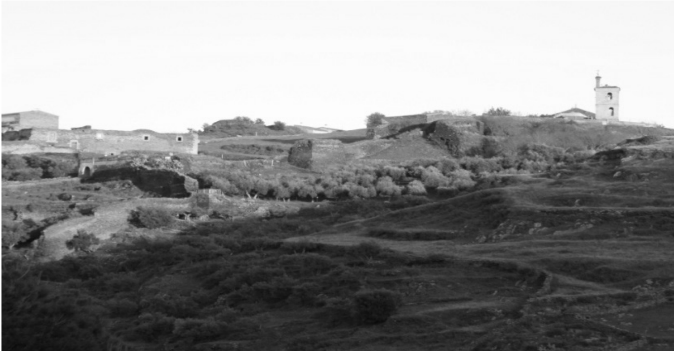
Lám. 3. Vista parcial del castillo.
