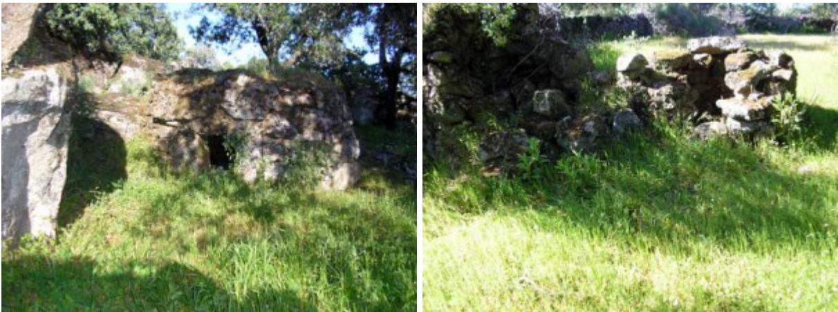
Muros circulares con falsa cúpula.
