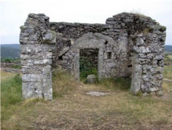
Ermita San Albin: "In antis ". Puerta adintelada.
