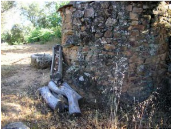
Muro de acceso al lagar.
