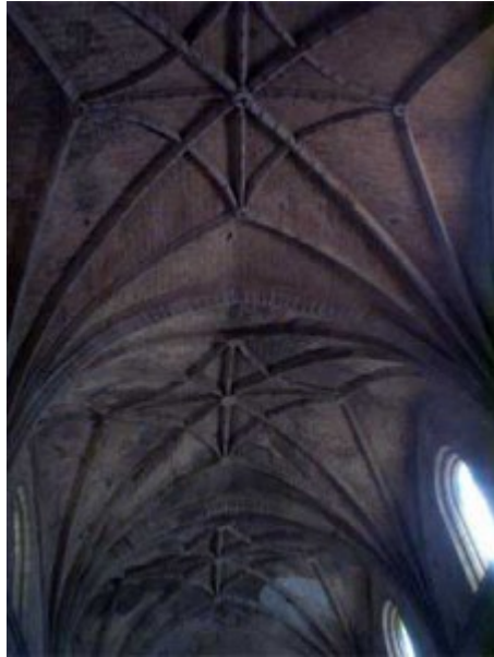
Detalle de la Bóveda.
