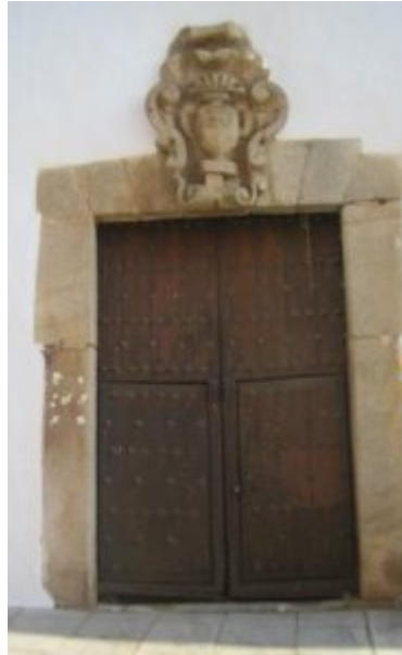
Figura 1. Portada del edificio que fue Hospital de San Juan Bautista (Hospital de hombres), que hoy forma parte del Parador de Turismo. Fuente: Archivo fotográfico de José Pastor Villegas, fotografía realizada por el autor el 29 de septiembre de 2011.
