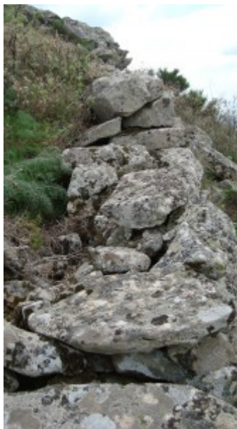
Lámina VI.- Las grandes piedras que forman la parte superior del muro oeste.
