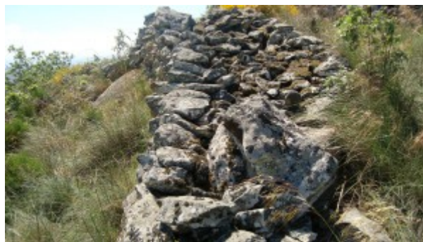
Lámina III.- Estructura interna del muro en la parte este del recinto.
