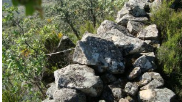
Lámina II.- El cambio de estructura en los inicios del muro sur por el este.
