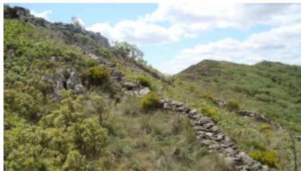
Lámina VII.- El muro oeste desciende más allá del recinto medio.
