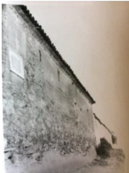
4. Exterior de la casa de Sta María antes de la restauración
