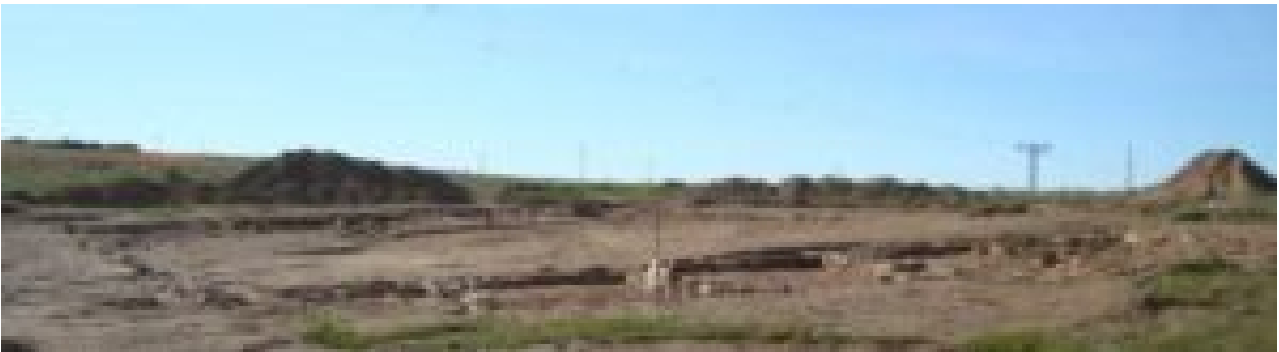
Lám 3. Actuación nº 3. Vista general desde el este
