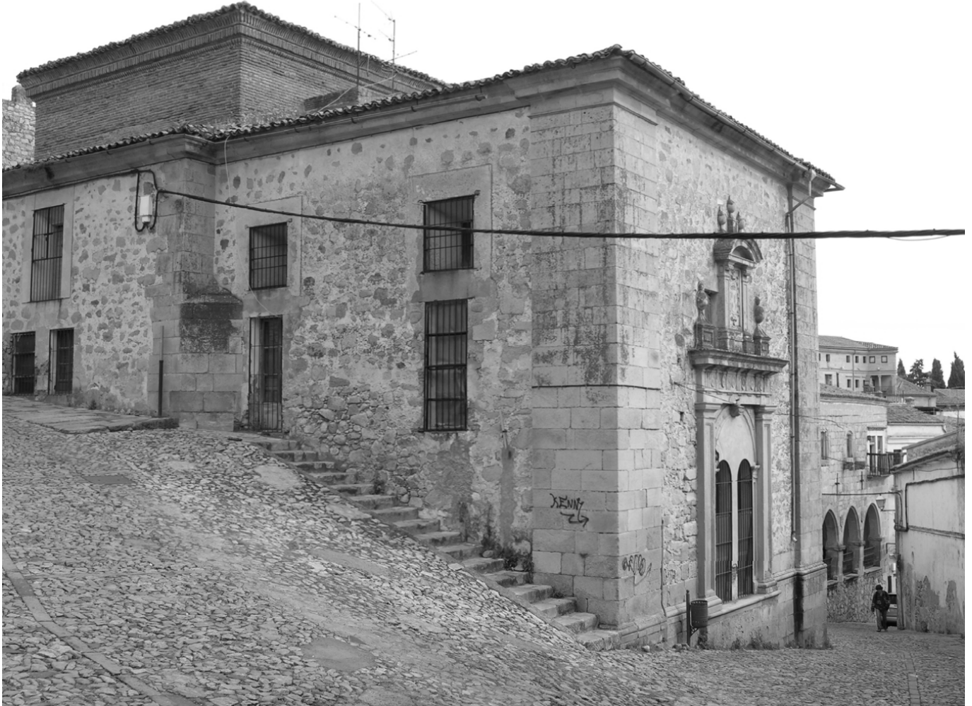
Lám. 1. Vista actual de la iglesia de la Sangre, fachadas nortes y oeste (Fot. BMD).
