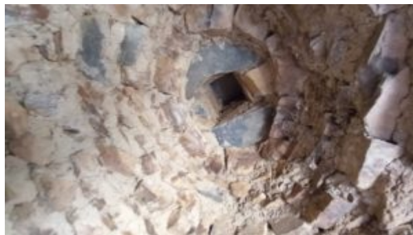
Imagen 1: Detalle cúpula de pizarra. Lavaderos.
