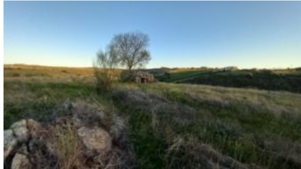
Imagen 9: Vista bujío roto. Casancabo
