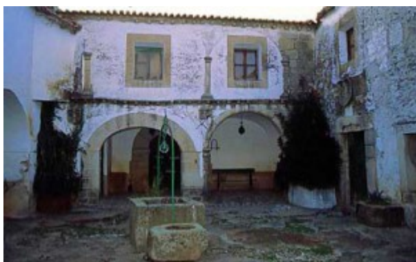
Fig. 6: Casillas. Patio interior
