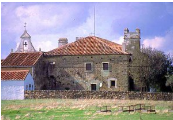
Fig. 17: El Carrascal. Aspecto exterior
