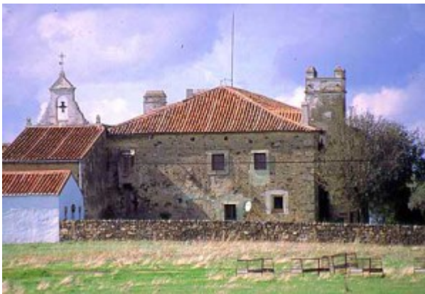
Fig. 17: El Carrascal. Aspecto exterior
