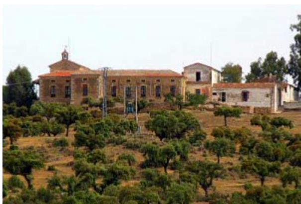
Fig. 19: Las Alberguerías. Aspecto exterior
