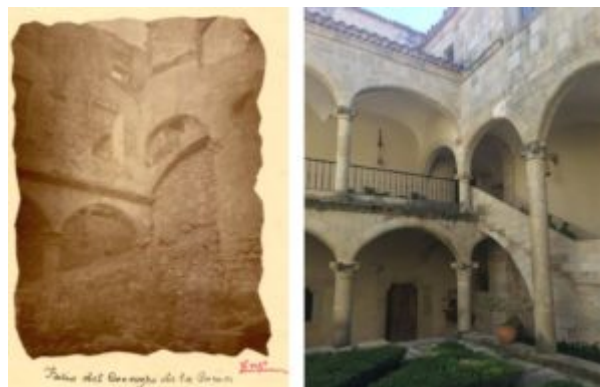
Fig 3. Claustro del convento de la Coria, antes y después de su restauración
